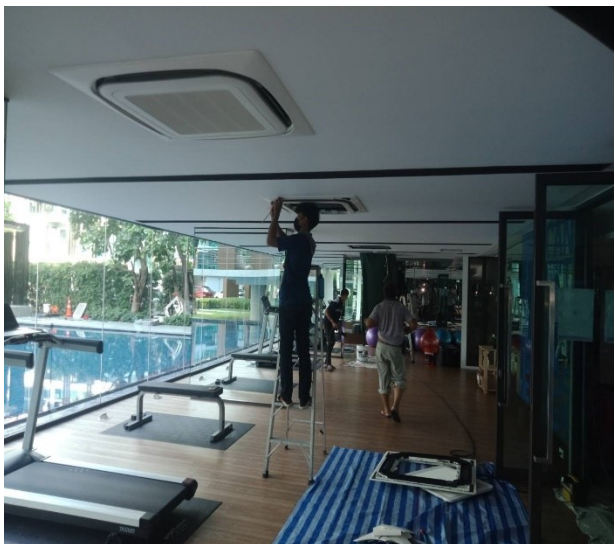
ภาพที่ 22 การทำความสะอาดเครื่องปรับอากาศภายในโครงการ
