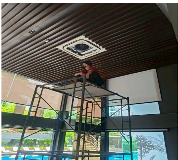
ภาพที่ 22 การทำความสะอาดเครื่องปรับอากาศภายในโครงการ
